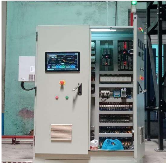
Gambar 2.9. Mesin pengontrolan Metode Insinerasi Sumber: Data Penelitian (2023)
