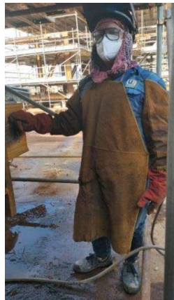
Gambar 1.1 APD Karyawan Departement Welder PT Wasco Engineering Indonesia Kota Batam
