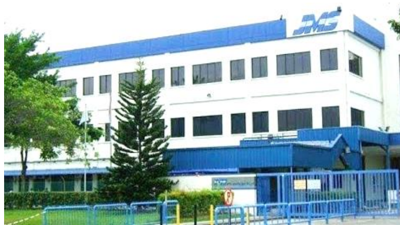
Gambar 3.6 PT JMS Batam Tampak Dari Depan Jalan Kawasan Industri Batamindo
