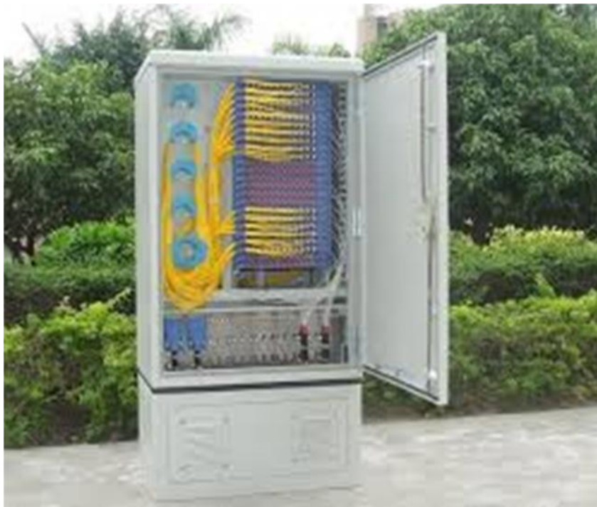
Gambar 2.20 ODC dan passive splitter
