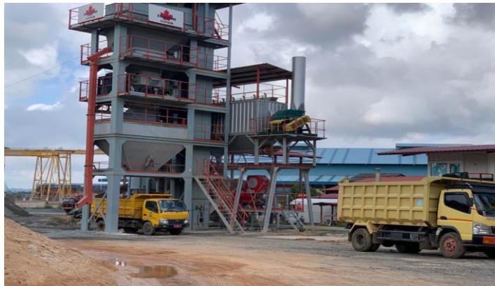
Gambar 2.17 Proses Loading Material Aspal Sumber: Arsip PT. Pulau Bulan Indo Perkasa
