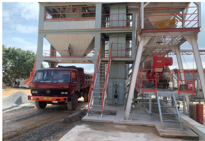
Gambar 2.18 Proses Loading Material Aspal Sumber: Arsip PT. Pulau Bulan Indo Perkasa
